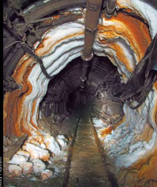
Częściowo zabarwione naloty gąbczaste na stalowej obudowie chodnika
